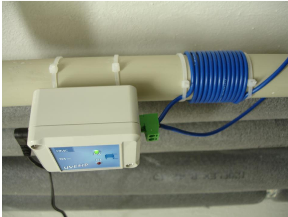
Obr.1. Uchytenie prístroja a cievky na potrubí
